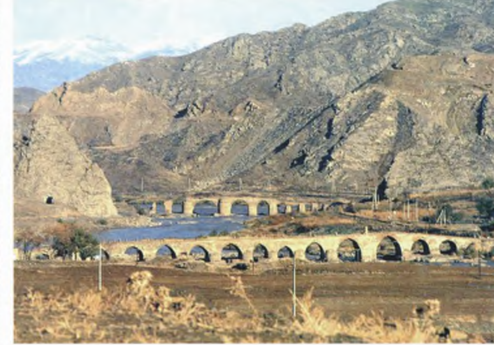
Xudafərin körpülərinin ümumi görünüşü. Qumlaq kəndi. XI-XII əsrlər. General view of Khudafarin Bridges. Gumlag Village. 11th-12th century
