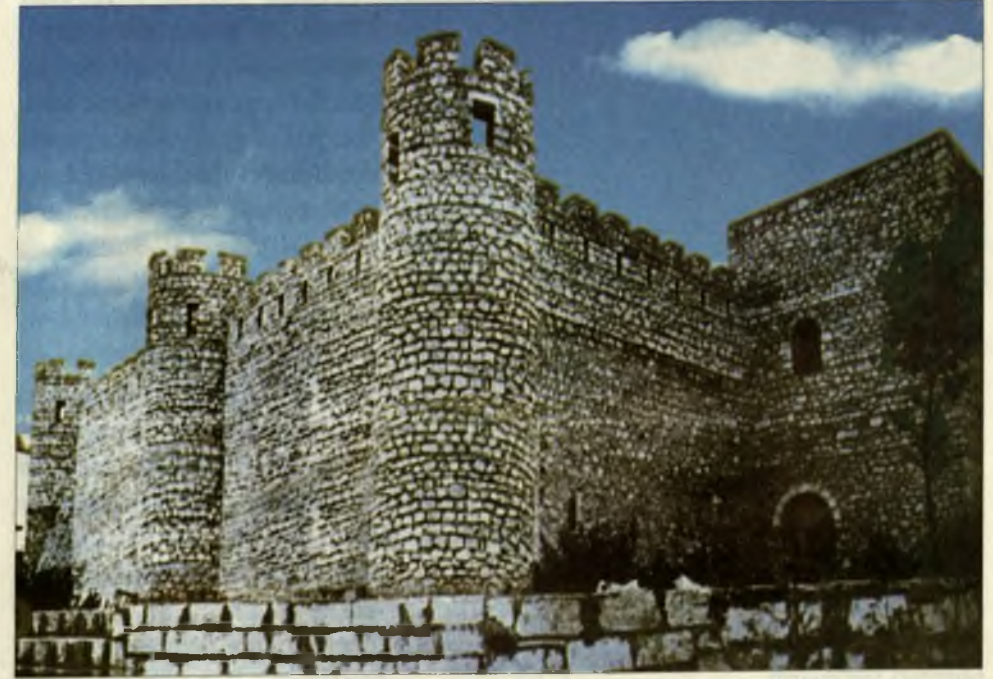
Şuşa – Pənahabad şəhərində Pənahəli xanın qəsri
