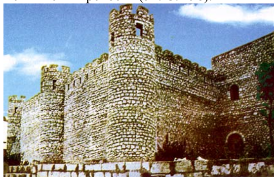
Замок Панахали хана (после реставрации)
