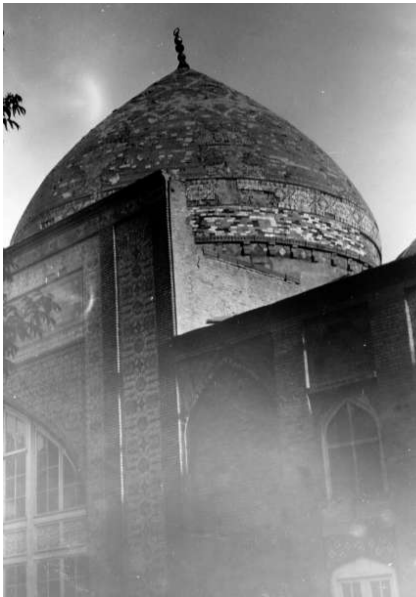
Photo 13: vue arrière de la grande mosquée à Irevan
