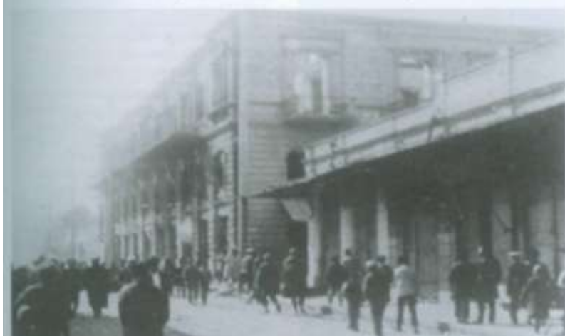
Дома и торговые объекты на ул. Почтовая - угол ул. Базарная, разгромленные и сожженные в дни мартовских событий 1918 г. в Баку
